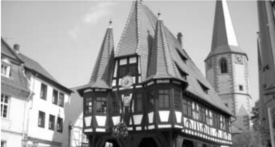
Das mittelalterliche Rathaus steht komplett auf Stelzen
